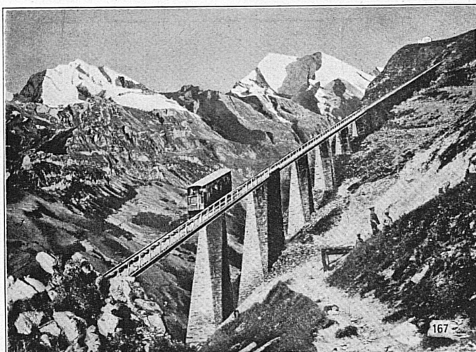
SEILBAHN NIESEN, Berner Oberland. Totale Länge 3496 m, überwundene Höhe 1645 m, Maximalsteigung 68%
