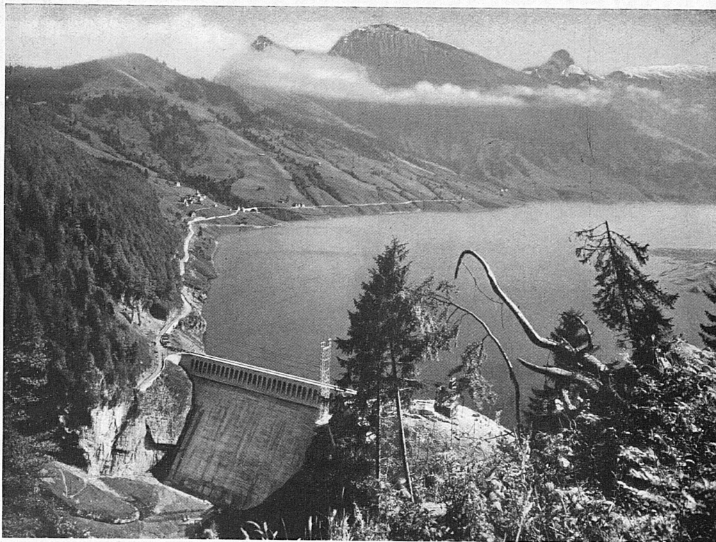
Staumauer im „Schräh“, Wäggitäl
