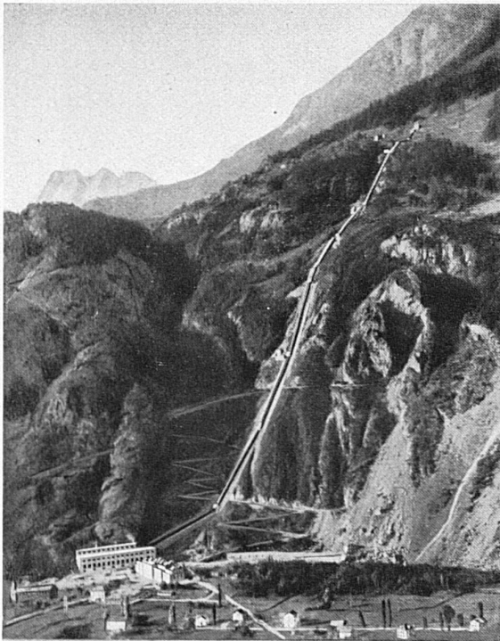
Ansicht der Hochdruck-Wasserleitung Vernayaz
