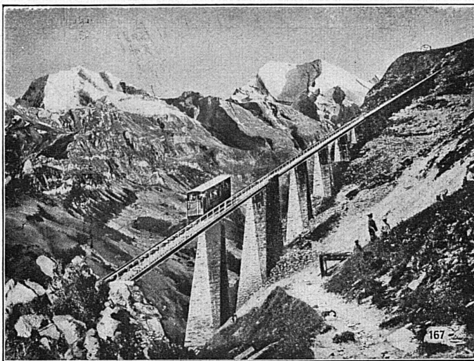
SEILBAHN NIESEN, Berner Oberland. Totale Länge 3496 m. überwundene Höhe 1645 m. Maximalsteigung 68%
