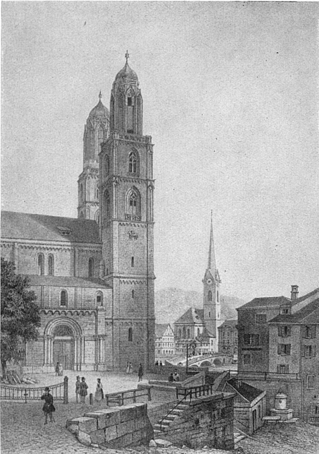
Das Grossmünster in Zürich Gez. von Deroy
