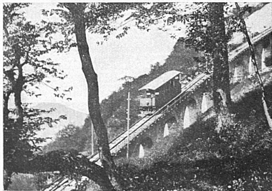
Drahtseilbahn Cassarate-Monte Brè bei Lugano
