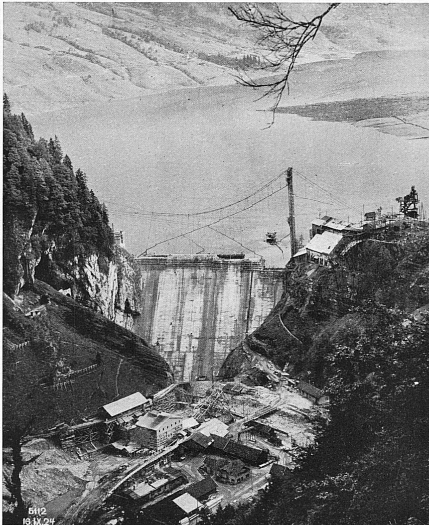
Staumauer im „Schräh“, Wäggital, mit Installationsanlagen gemeinsam ausgeführt mit Firma Ed. Züblin & Co. A.-G., Zürich
