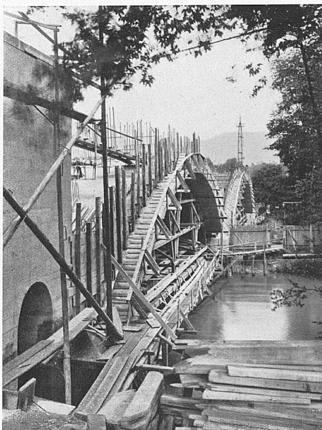
Vom Bau der Kornhausbrücke Zürich
