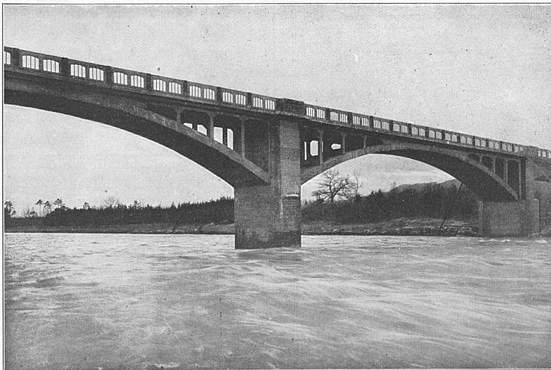
Strassenbrücke über die Thur bei Weinfelden
