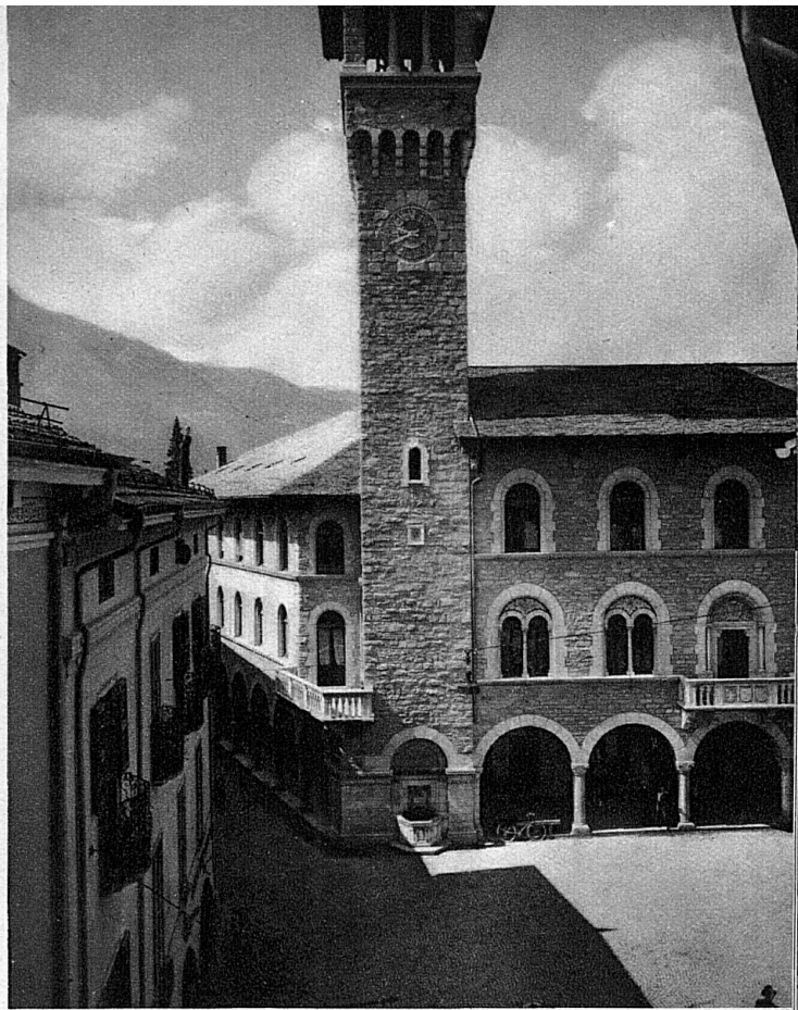
Das neue Stadthaus von Bellinzona / Il nuovo palazzo di città di Bellinzona / Le nouvel Hôtel de ville de Bellinzone
