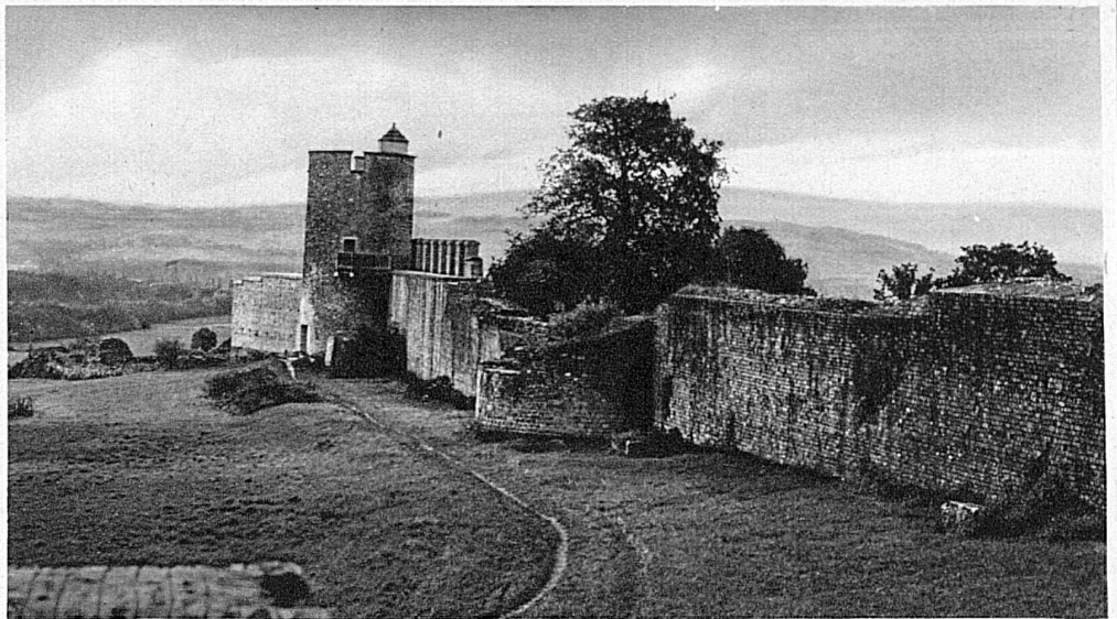
„La Tornallaz“, der besterhaltene römische Wachturm und ein Stück der römischen Umfassungsmauer. Die römische Umfassungsmauer war 6–7 km lang, 3 m dick, 5–6 m hoch, und trug vermutlich 80 Wachtürme. Sie sollte das römische Aventicum gegen allfällige feindliche Angriffe schützen. Aber die alemannische Zerstörungswut liess auch davon der Nachwelt nur spärliche Reste zurück.
