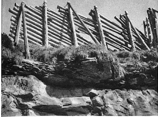
Machtvolle Lawinengitter schützen die Geleise vor Schneerutschungen und Steinschlag
