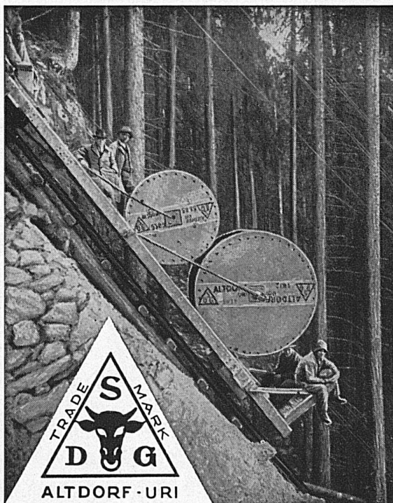
Verlegung der Bleikabel für KW-Sernf-Niedererbach.
