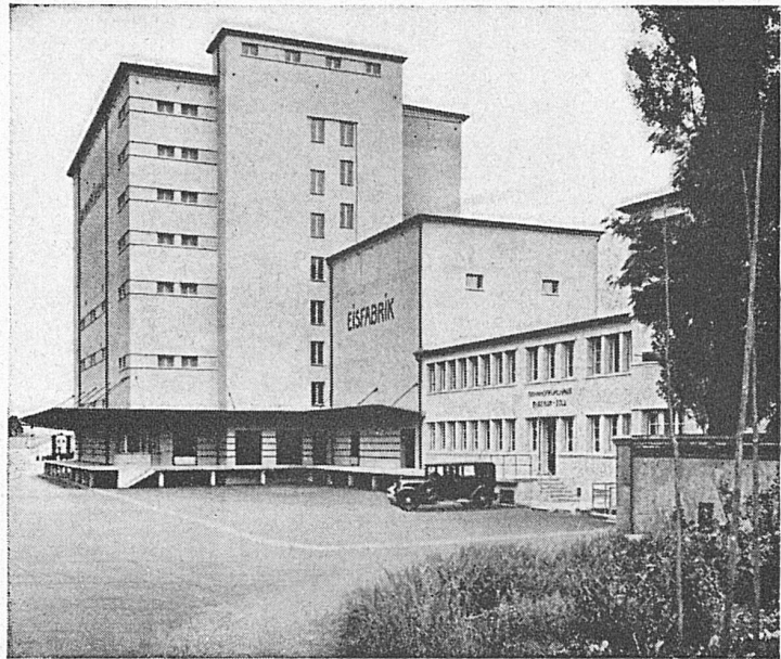
Hauptansicht des Bahnhof-Kühlhauses
