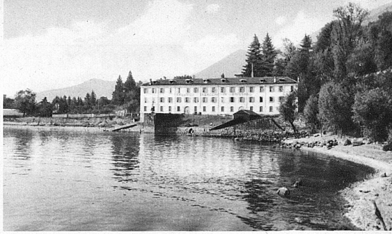
Fabbrica Tabacchi in Brissago, wo die Blauband-Brissagos hergestellt werden
