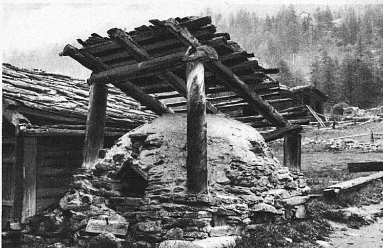
Im Wallis findet man noch uralte, primitive, nur mit einem kleinen Schirmdach überdeckte Backöfen im Freien
