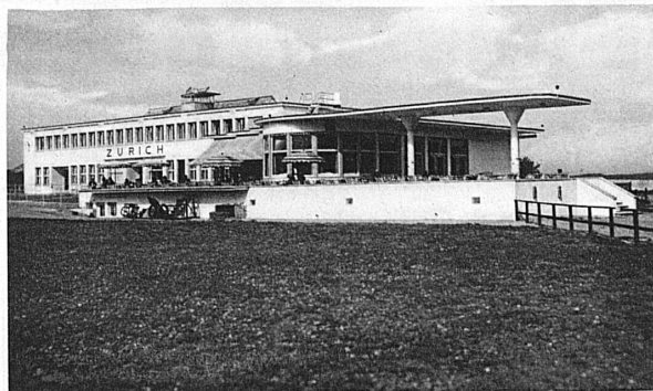
Grossrestaurant Zivilflugplatz Dübendorf Architekten: Kündig & Oetiker, Zürich
