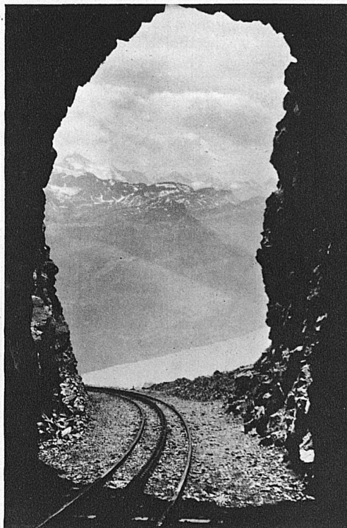
Briener Rothornbahn. Der letzte Tunnel unterhalb des Gipfels
