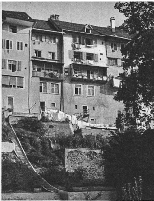
Stück von der ehemaligen Stadtmauer
