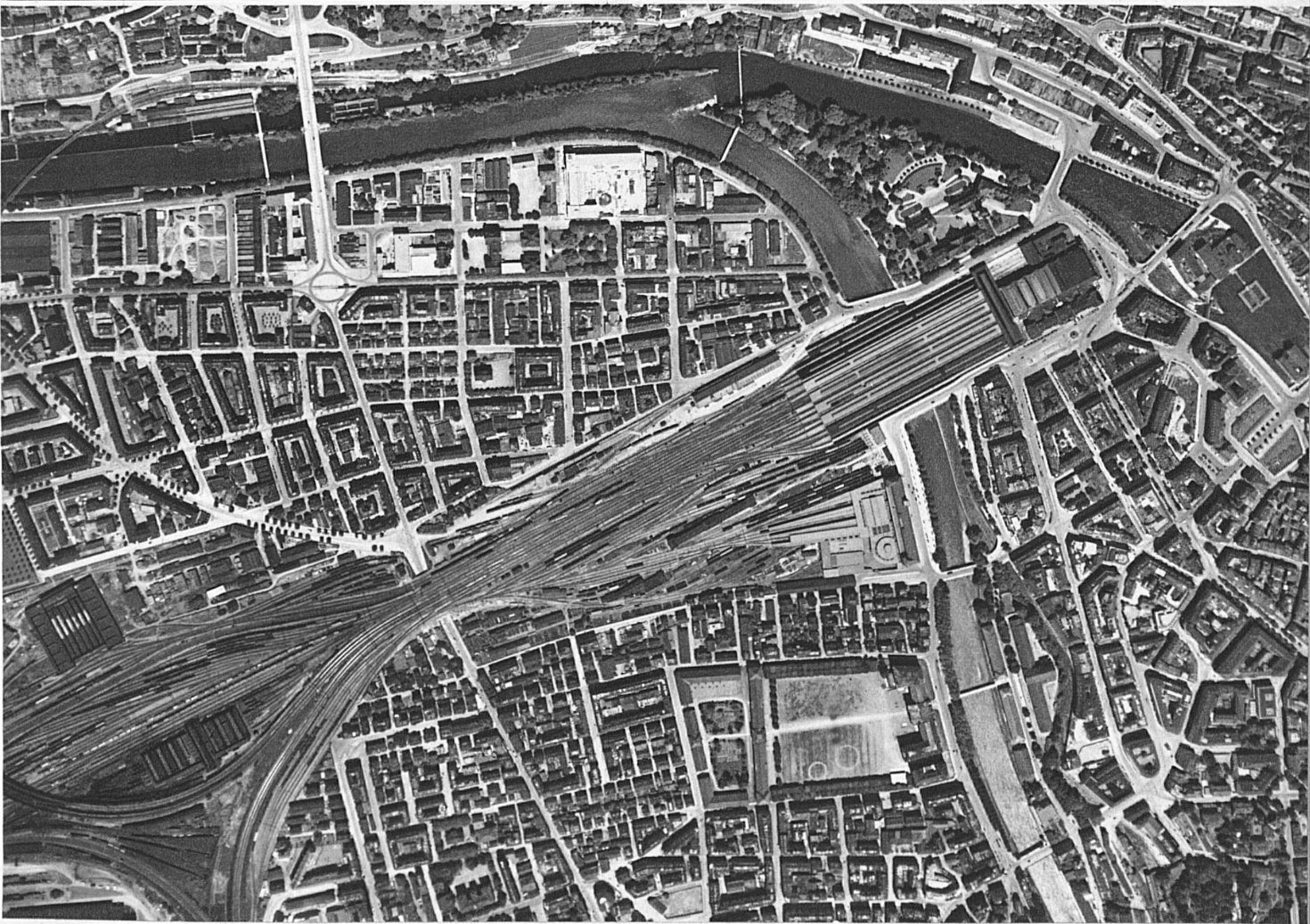
Der Zürcher Kopfbahnhof liegt im Zentrum der grossen Industrie- und Handelsstadt. Die aus südlicher und östlicher Richtung kommenden Linien biegen in grossem Bogen in die mächtige Anlage ein
