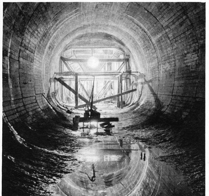
Der Einlaufstollen führt das Wasser von der Druckleitung zu den Turbinen - Le tunnel d'amenée
