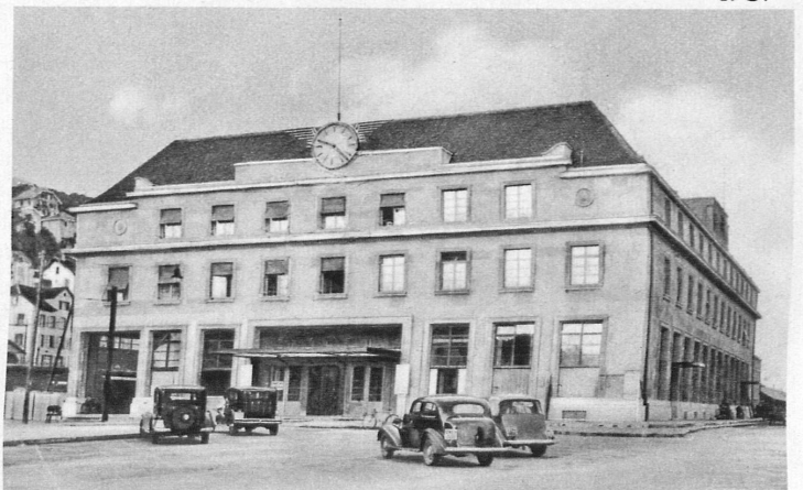
Der neue Bahnhof Neuenburg wurde soeben vollendet (Favag, Neuenburg, die schon 80 Bahnruhren geschaffen, lieferte die Uhren, Ventilator AG., Stäfa, richtete die Ventilationsanlagen ein; Dubied & Cie., Neuchâtel, die Kühlanlagen) – La nouvelle gare de Neuchâtel (Horloges de Favag, Neuchâtel, le grand spécialiste des horloges de gares, ventilation de Ventilator S. A., à Stäfa, refroidissement de Dubied & Cie, Neuchâtel)
