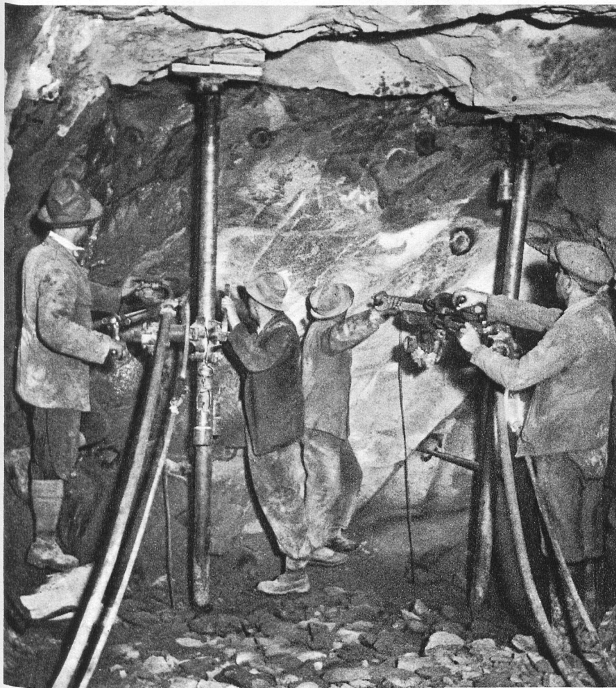
Im Ceneretunnel — Tunnel du Monte-Ceneri
