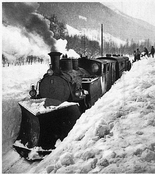
Gewaltige Schneemassen bedecken jeden Winter das Trasse der Furka-Oberalp-Bahn. Schneepflug und zahlreiche Arbeiter halten das Geleise frei – Le chasse-neige et l'équipe alerte des déblayeurs s'unissent pour frayer un passage aux trains de la ligne Furka-Oberalp
