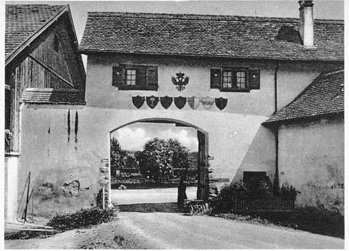
Einfahrt in den Hof des ehemaligen Klosters «Im Paradies» bei Langwiesen – Porche du Couvent du Paradis à Langwiesen
