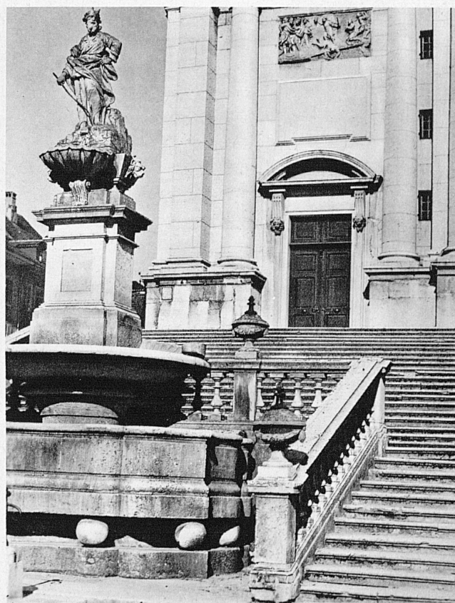
Escalier monumental de la cathédrale de St-Ours à Soleure - Der Aufstieg zur St. Ursenkathedrale in Solothurn - Steps leading to portal of St. Ursen Cathedral, in Solothurn - La scalinata alla Chiesa di S. Orsio a Soletta
