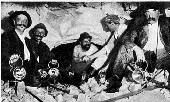
Der Tunneldurchstich im Jahr 1911 – La percée du tunnel en 1911
