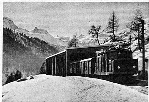
Galerie de protection contre les avalanches sur la ligne Viège-Zermatt - Lawinenschutzgalerie auf der Linie Visp-Zermatt
