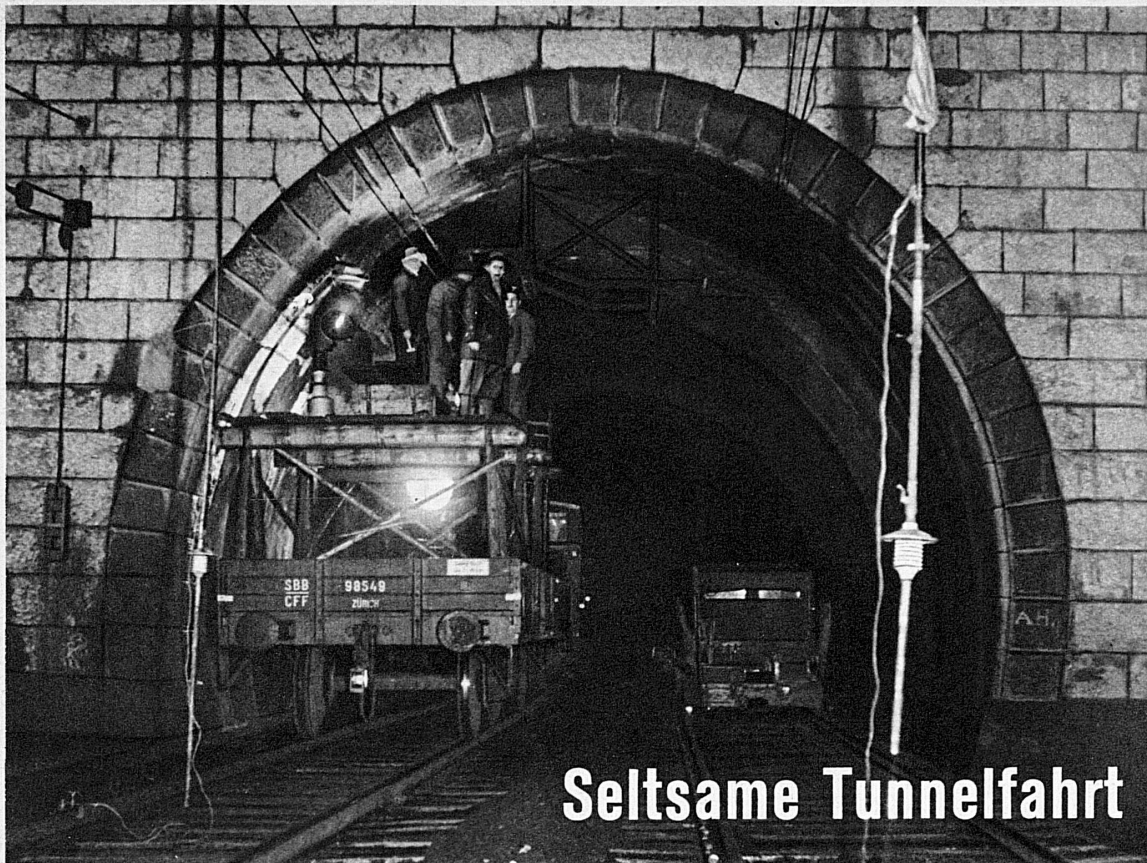
Einfahrt in den Tunnel. Im Vordergrund die Erdungsstangen, links der Kontrollzug mit einem hölzernen Aufbau, rechts die kleine Draisine des Fahrleitungs-monteurs
