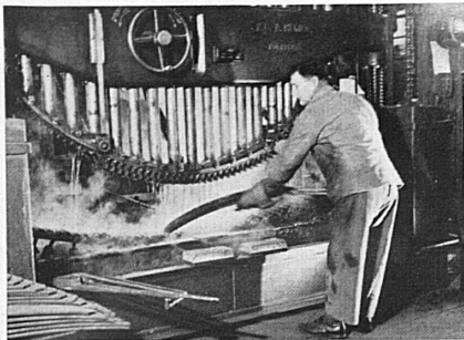
Links: Biegen und thermische Behandlung eines Lokomotiv-Tragfederblattes.
