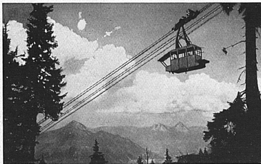
Liftseilbahn Beckenried - Klewenalp
