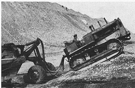
Train de scrapers, 120 CV., 22 tonnes. Chantier Lonza, Viège.
