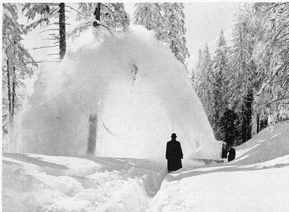
Schneefräsmaschine „Peter“ in etwa 1,5 m hoch gelagerter Schnee in voller Tätigkeit
