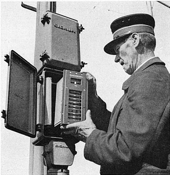
Ein leicht auswechselbares polarisiertes Relais steuert über zwei Kabelleitungen die drei Begriffe « halb, gerade Fahrt und ablenkende Fahrt » am Lichtvorsignal und stellt die Verbindung mit den Geleisemagneten der automatischen Zugsicherung her.
