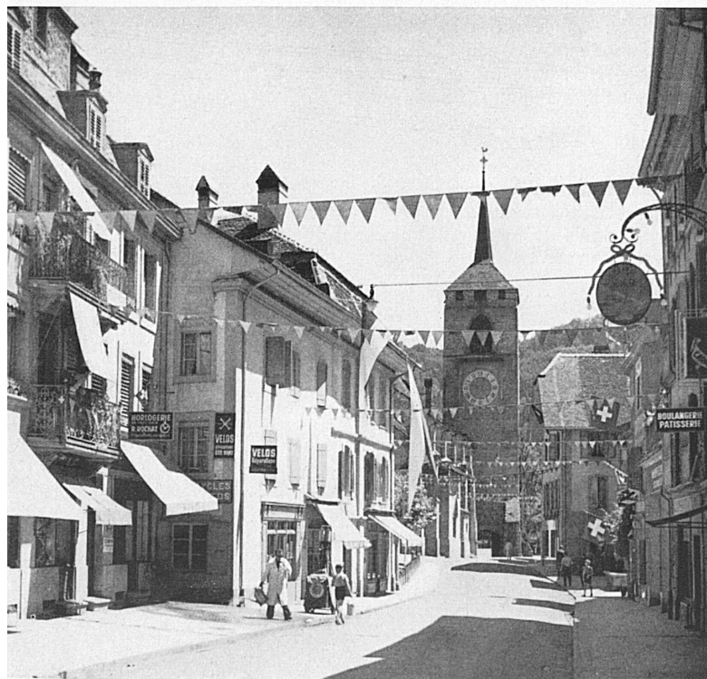
Die beflaggte Hauptstraße von Moudon anlässlich der Einweihungsfeier des elektrischen Betriebes. — La rue principale de Moudon pavoisée lors des fêtes d'inauguration de la nouvelle ligne électrifiée. Phot.: SBB.
