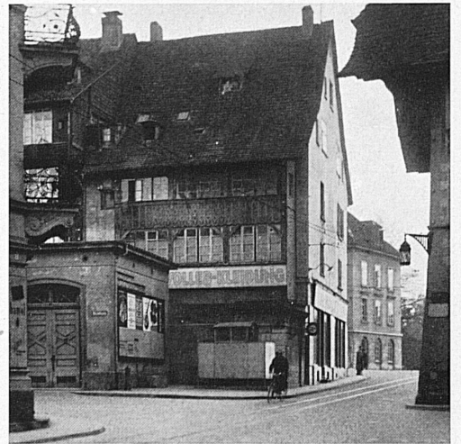
Der charakteristische Bau der «Obere Mühle» in Aarau soll nach dem Willen der Gemeindeversammlung abgebrochen werden. Dabei wäre die notwendige Straßenverbreiterung ebensogut oder noch viel besser durch die Entfernung der gegenüberliegenden, unschönen Häuser möglich. — Une construction caractéristique l'«Obere Mühle» à Aarau est menacée de destruction par une décision de l'Assemblée municipale. On pourrait, semble-t-il, tout aussi bien élargir la route en démolissant les maisons d'en face, peu esthétiques.
