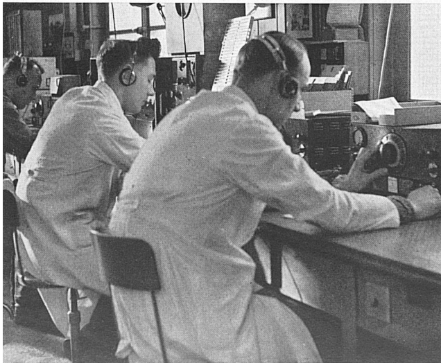
Unten: In der Zentral-Funkstation werden täglich Tausende von Meldungen aus ganz Europa empfangen und gesendet. — Unten Mitte: Auf Grund der Peilungen kann der jeweilige Standort eines sich auf der Strecke befindenden Flugzeuges bestimmt werden.
