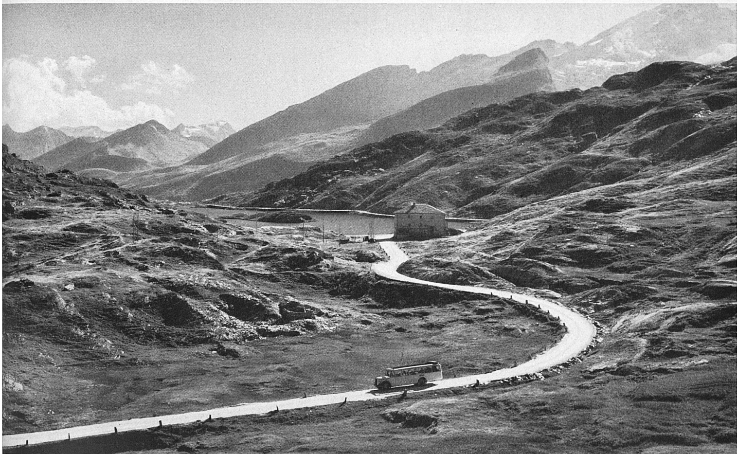
Auf der St.-Bernhardin-Paßhöhe. Im Hintergrund die Misoxer Berge. — Au sommet du col du San Bernardino. A l'arrière-plan, les montagnes du Val Mesocco. Photo: PTT/Fr. Schneider.
