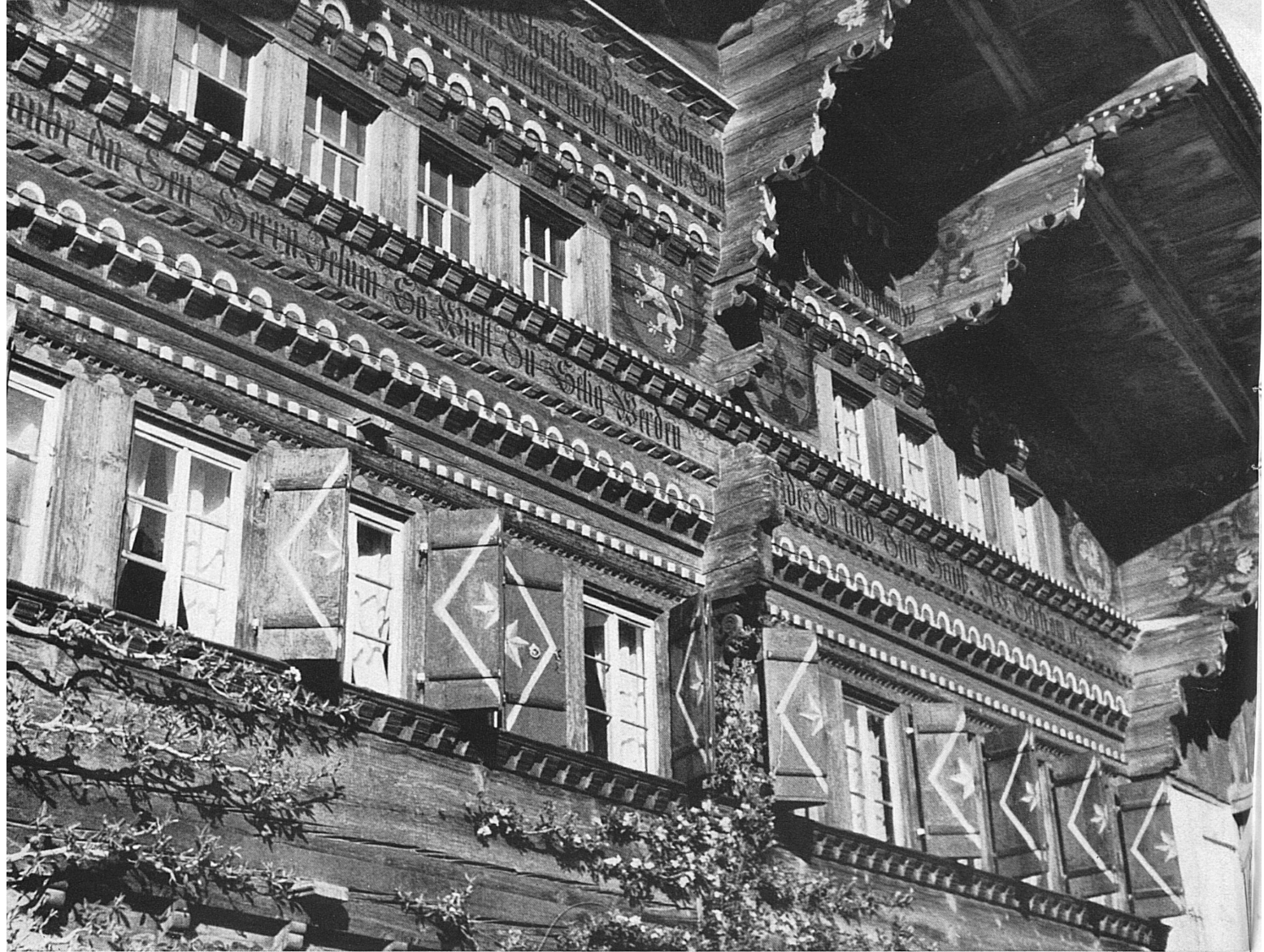
Oben: Reich ornamentierte Fassade eines Berner Oberländer Hauses. Photo: Villiger.
