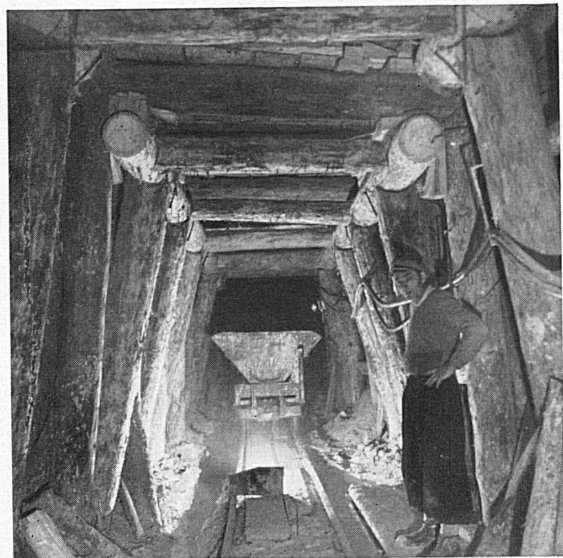
Stollen mit schwerem Einbau
