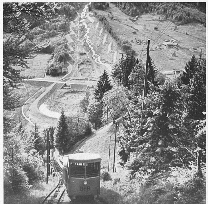
Rechts: Braunwald ist mit Linthal durch eine jüngst modernisierte Drahtseilbahn verbunden. Im Hintergrund die Verbauungen des «Durnagels», eines böartigen Wildbaches. — A droite: Braunwald est relié à la vallée de la Linth au moyen d'un funiculaire rénové tout dernièrement. Photo: Schwabe.
