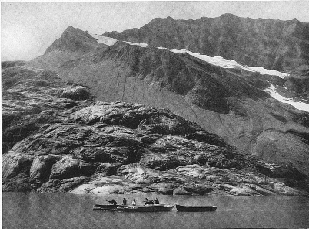
Oben: Vom jenseitigen Ufer des Barberine-Sees werden Sand und Kies an die Baustelle verbracht. – Ci-dessus: De l'autre côté du lac, on amène au chantier sable et gravier.
