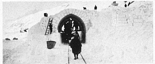
Oben: Provisorische Erstellung einer Schutzgalerie an der Oberalp. – Ci-dessus: Erection provisoire d'une galerie de protection sur la ligne de l'Oberalp. Photo: Bucher
