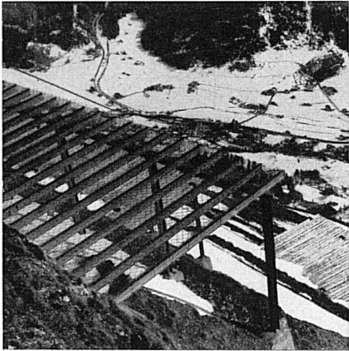
Ci-dessous: Le plus moderne des systèmes de protection, réalisé en partie avec des treillis. Installation modèle, érigée d'après les données de l'Institut pour l'étude de la neige et des avalanches.
