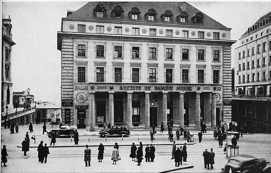
Hôtel de la banque à Lausanne – Bankgebäude in Lausanne
