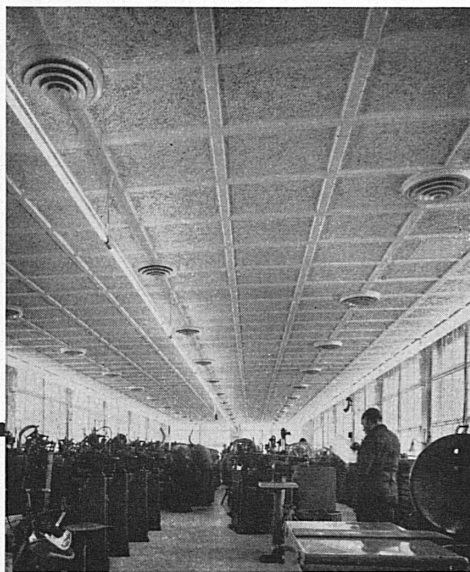
Klimaanlage «System Häusler» in Uhrenfabrik
