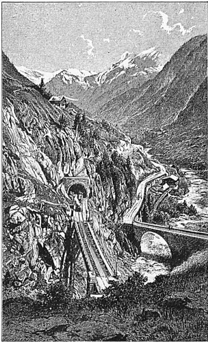
Mühltunnel ob Wassen
