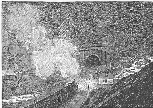
Gotthardtunnel um 1895 Le tunnel du Gotthard vers 1895 La galleria del Gottardo verso il 1895 El túnel del San Gotardo hacia el 1895 Gotthard Tunnel about 1895
