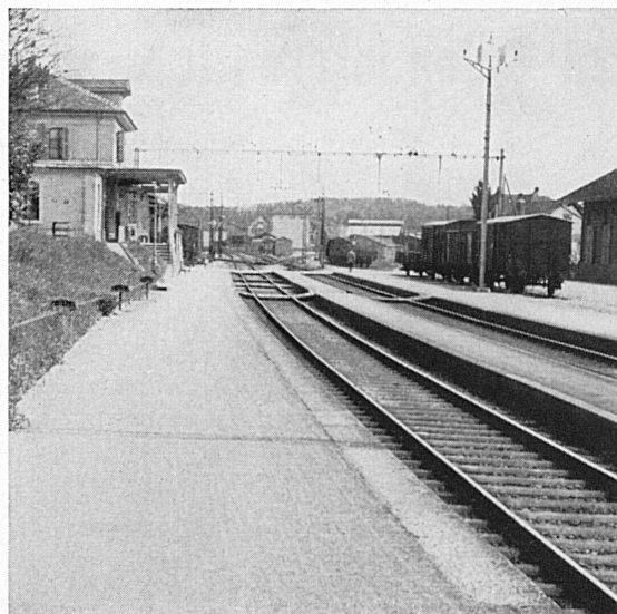
Bussigny, Bahnhofquai mit Olmax-Belag
