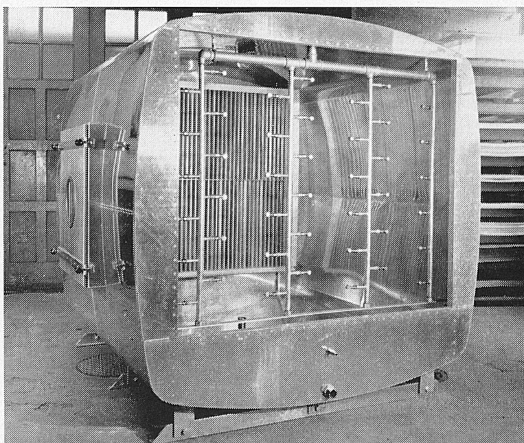
Luftwäscher und Befeuchter aus Aluminium geschweißt
