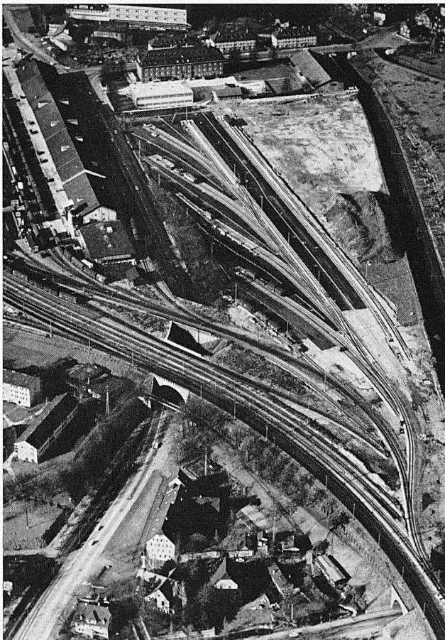
Ausbau Basel GB
