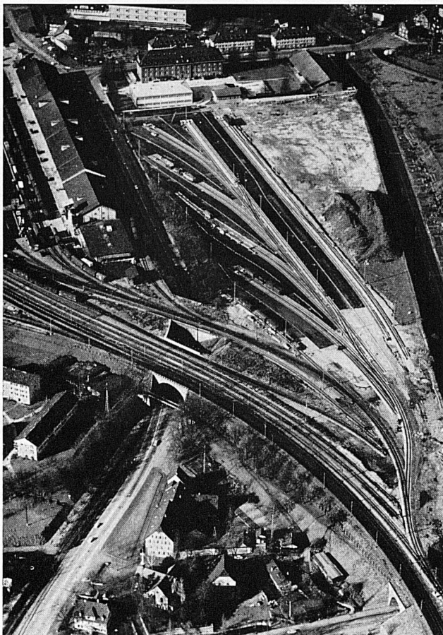
Ausbau Basel GB
